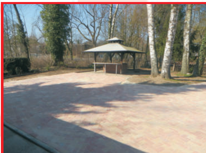
Außenanlage der Grillhütte nach der Sanierung 2015
